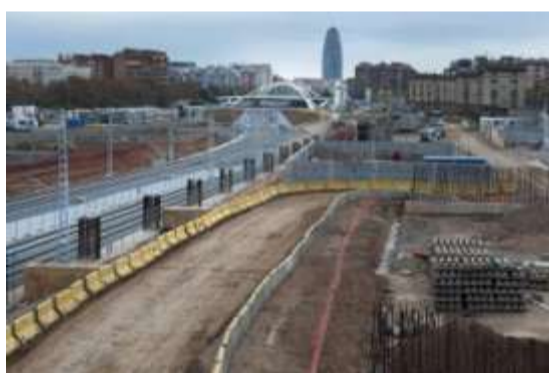
Chantier de la gare de La Sagrera
